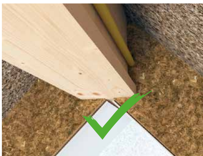
Nok volledig vullen met Isovlas
